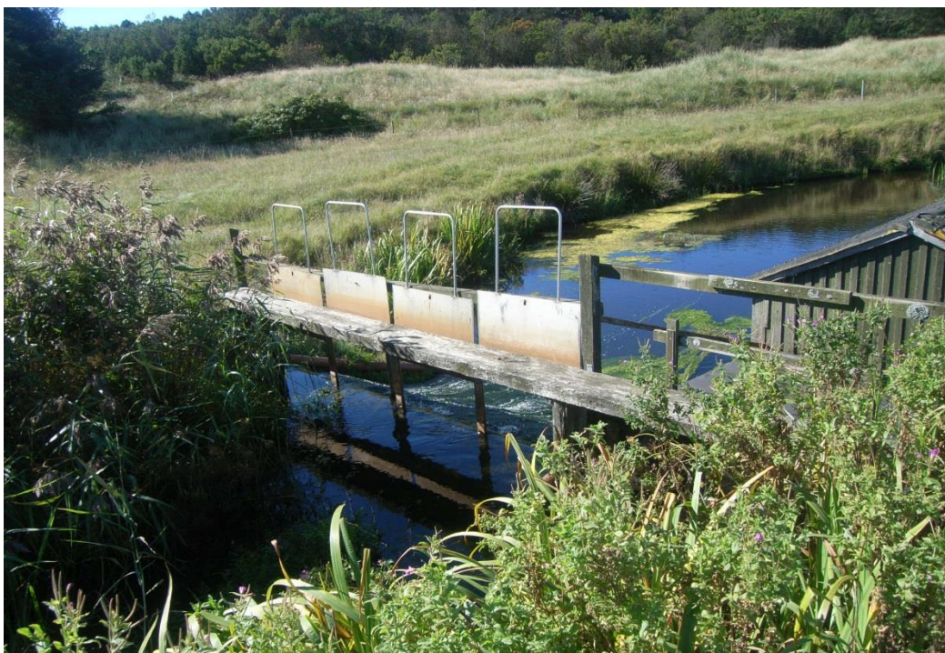
Figur 12.5 AAL-1129, spærring ved ålekiste.
