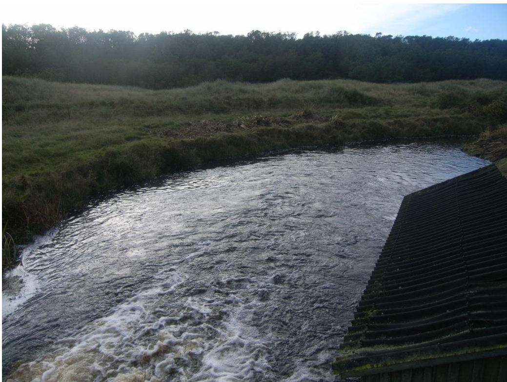
Figur 1.4 AAL-1129, spærring ved ålekiste.
