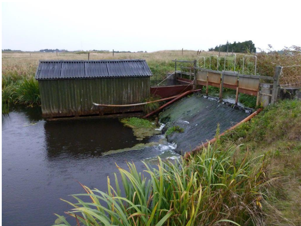
Figur 1.3 AAL-1129, spærring ved ålekiste.
