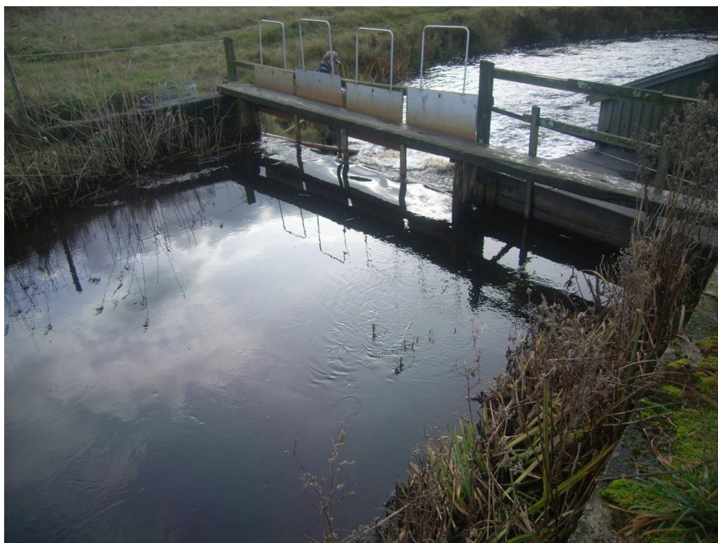
Figur 5.4.1: Eksisterende stemmeværk med ålekiste, der fjernes. Naturligt vandløbsprofil opbygges.
